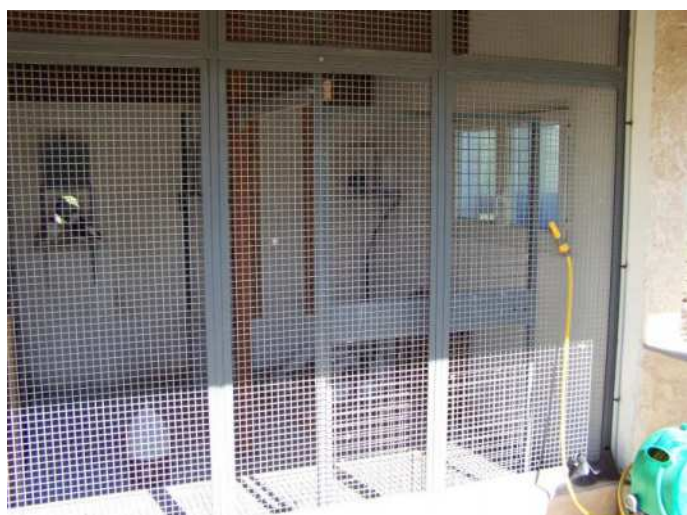
Façades en grilles métalliques très solides
